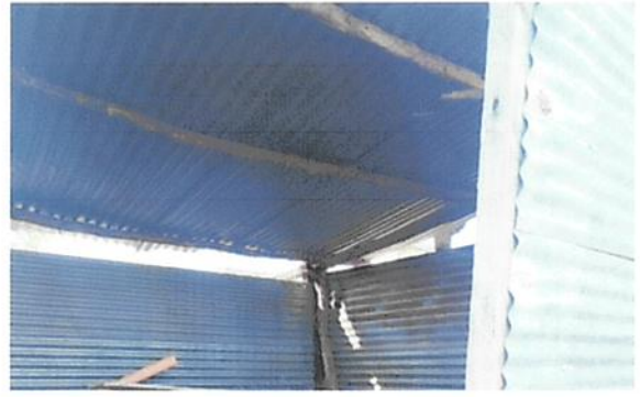
FOTO 2: CAMBIO DE TECHO
