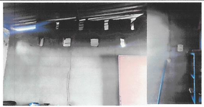
FOTO 6: REPELLO, CERNIDO, LLENADO DE AGUJEROS EN PARED Y CAMBIO DE INSTALACIONES ELÉCTRICAS
