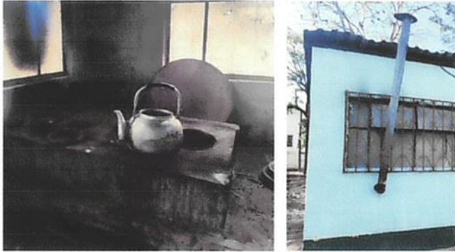
FOTO 1: SUSTITUCIÓN DE ESTUFA Y CHIMENEA
